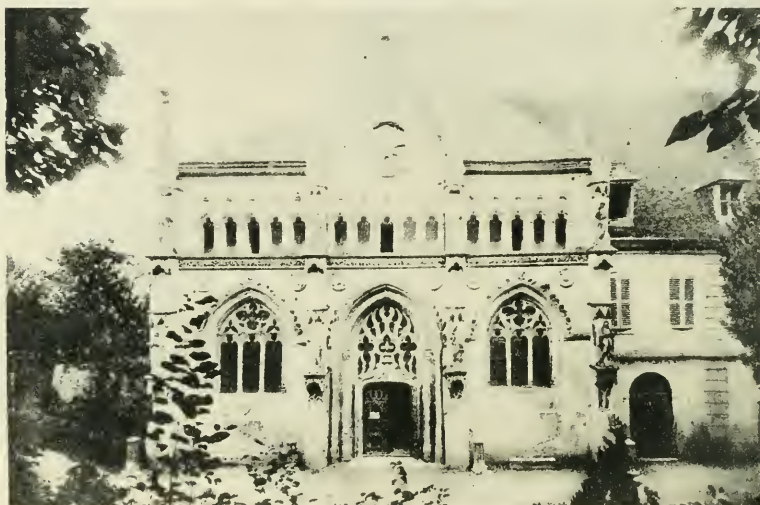
Entrée de l'abbaye d'Hautecombe
